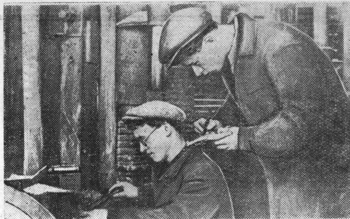
Студенты III курса факультета МТД проходят производственную практику на лесозаводе № 5-7. На снимке: Владимир Соколов и Александр Гнатюк снимают размеры нижнего прижимного вальца лесопильной рамы РД-75-2.
